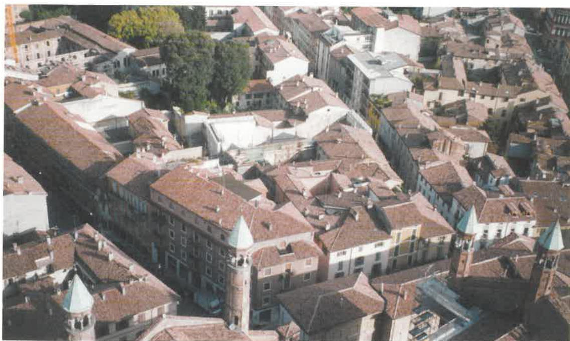
Vista dell'area destinata all'edificazione del Delle Arti Design Hotel, a Cremona.
